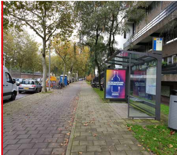
Figuur 26 Slechte bereikbaarheid abri vanaf de halte
